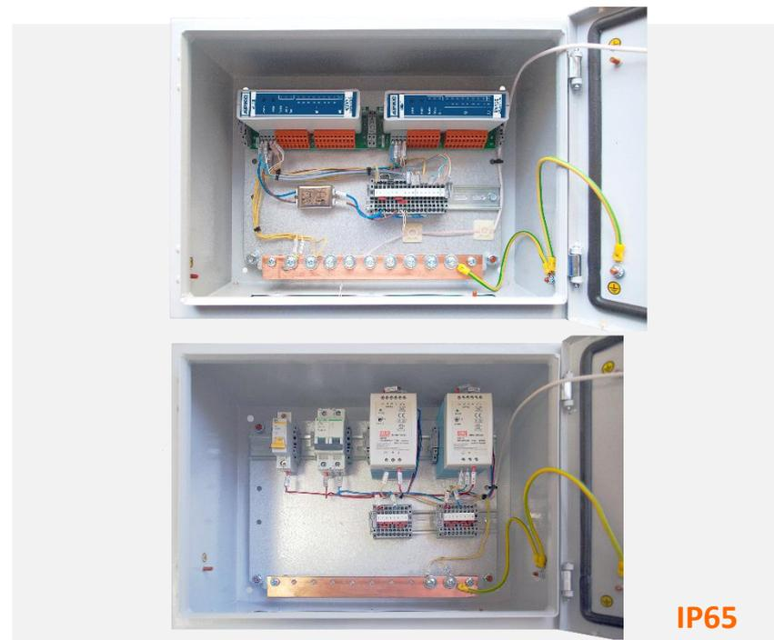
Подключение от 8 до 32 аналоговых датчиков различного типа при использовании модулей USO АРКС400
