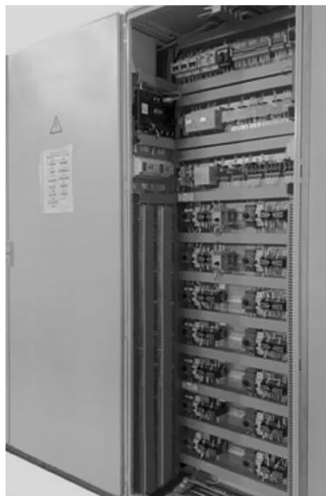
Рис. 4. Шкаф ИРТЗО на 14 присоединений
