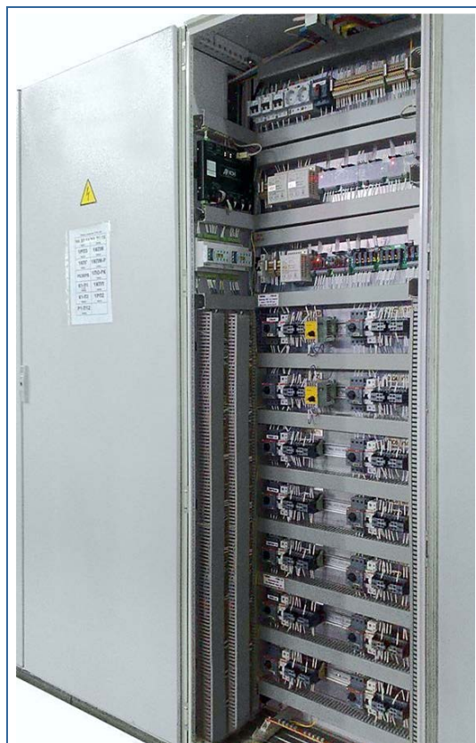
Рис. 2. Шкаф ИРТЗО на 14 присоединений
